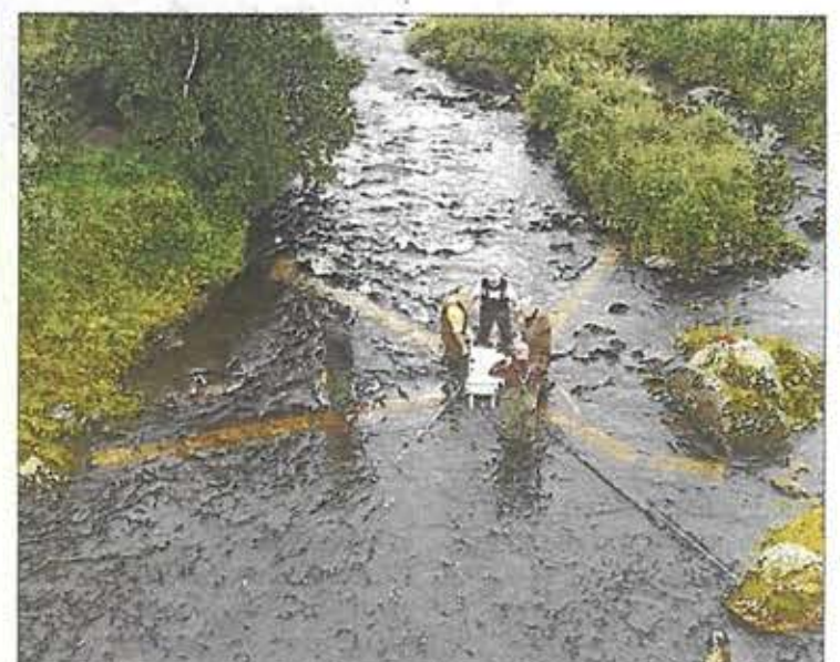
GJERDER: Det er lagt ut betongblokker i elva der det skal monteres gjerdet for å tvinge fisken til å svømme gjennom fotoboksen. FOTO: JØRN AUNE
